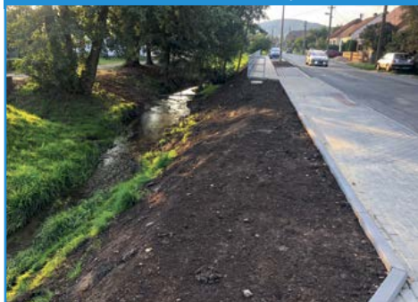
Rekonstruovaný chodník v Drnovicích zdroj: obec Drnovice
